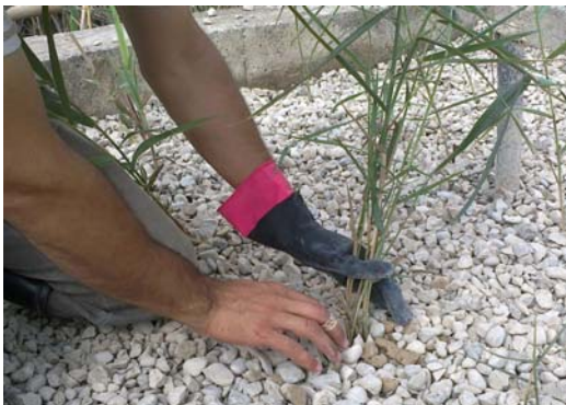
تصویر شماره ۴: انتقال و جابجایی و کاشت نی در حوضچه های نیزار
