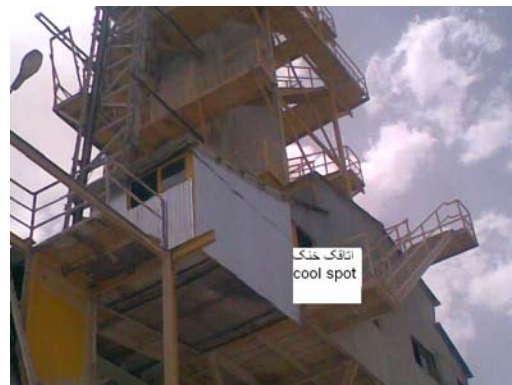
شکل شماره ۱: دور نمای اتاقک خنک (cool spot) طراحی شده در محل کوره کارخانه شیمی معدنی همدان
